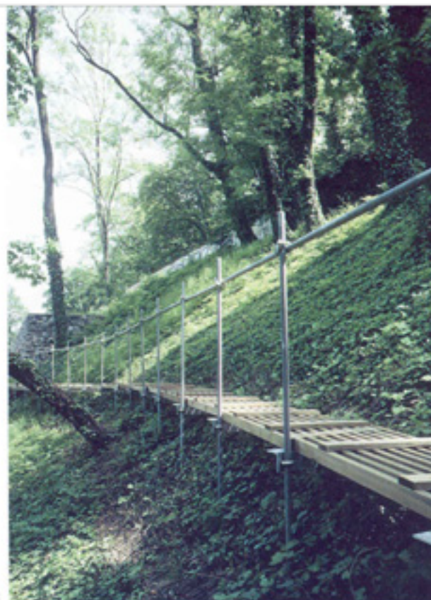
Pasarele și scări
