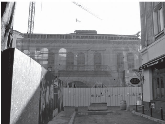
Fig. 3. Le Passage Commercial pendant les travaux de restauration. Novembre 2012.
