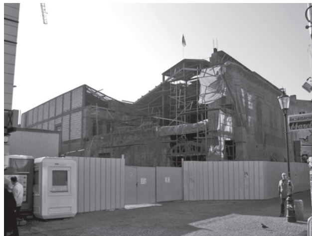
Fig. 4. Le Passage Commercial pendant les travaux de restauration. Novembre 2012.
