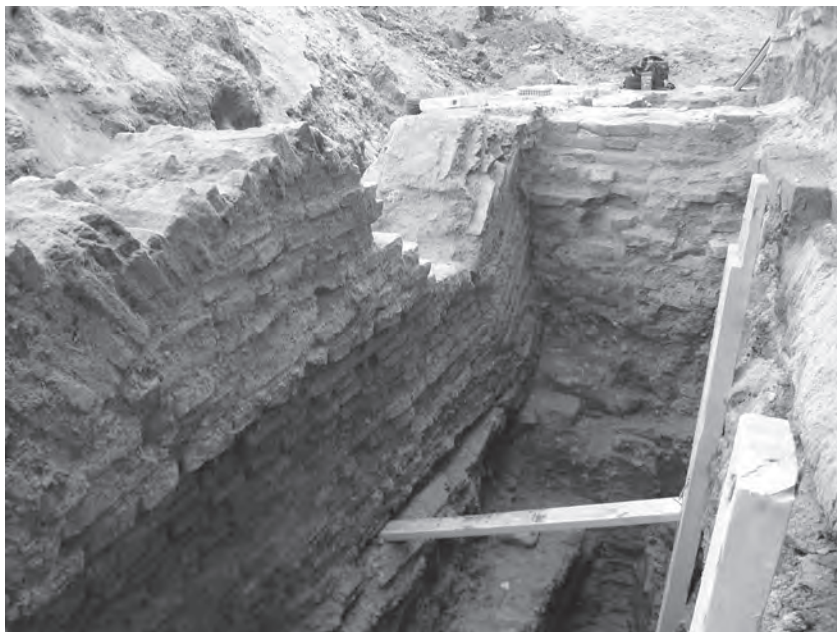
Fig. 1. Str. Smârdan – zona C. Arc de descărcare în zidul Z1.
