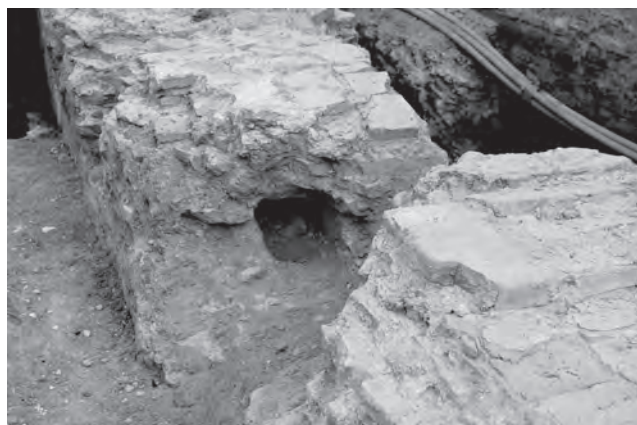
Fig. 9. Str. Lipscani – zona Hanul Zlătari / Faza I. Amprenta tirantului de lemn încorporat în masa zidului Z1.
