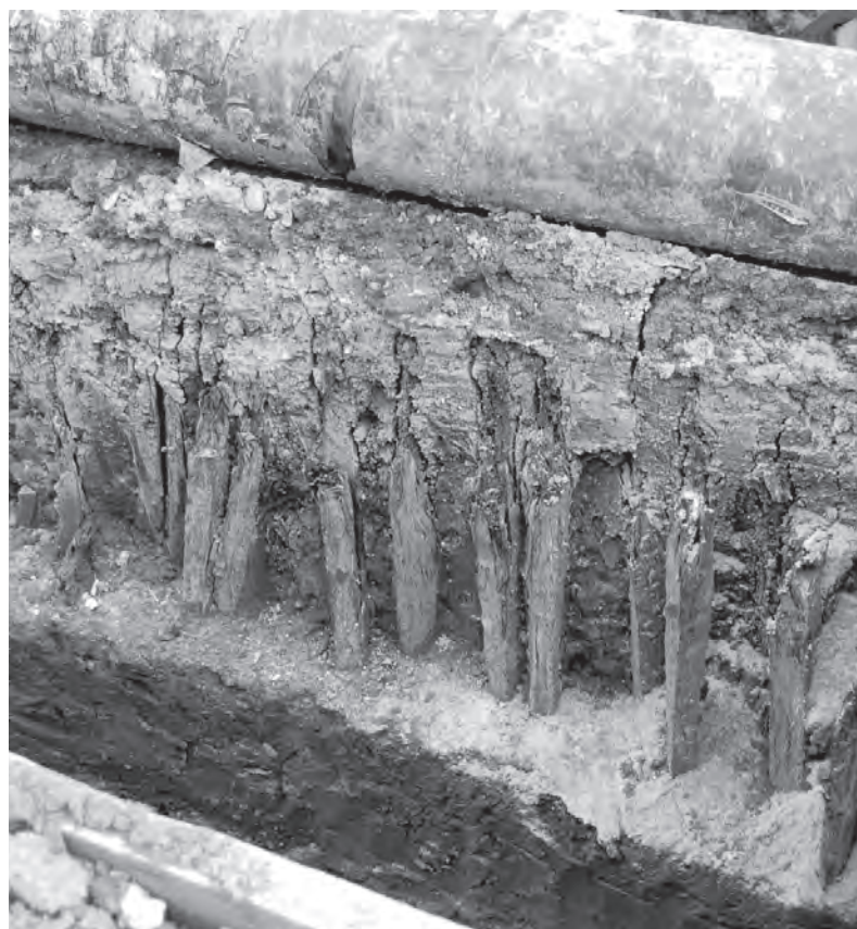
Fig. 13. Str. Lipscani – zona Hanul Greci. Pilotare sub zidul Z12.
