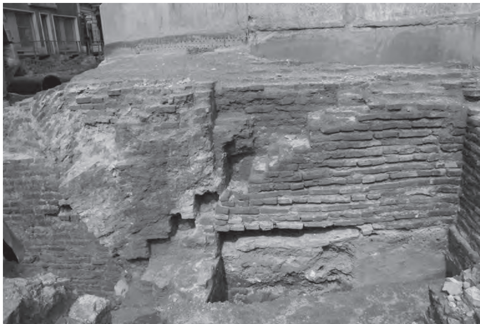
Fig. 23. Str. Franceză – str. Poștei. Amprenta scării spre pivnița / Faza I.
