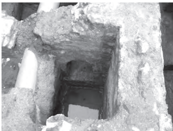
Fig. 34. Str. Pasajul Francez. Amenajare 1 (cămin colector?).
