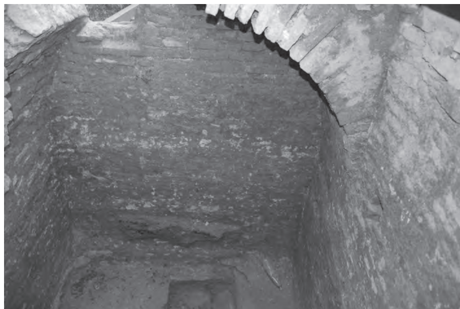
Fig. 12. Str. Lipscani – zona Hanul Greci. Încăperea 1 / Faza I – pivnița preluată.
