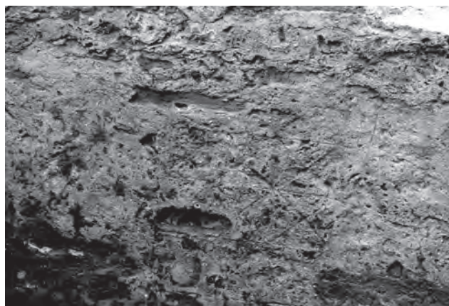
Fig. 28. Str. Pictor N. Tonitza. Detaliul de prelucrare a tencuielii zidului Z31.
