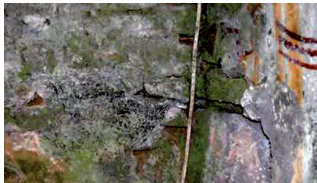
Fig. 26. Colonii fungice producătoare de pigmenți melanici (determină apariția petelor de culoare neagră).
