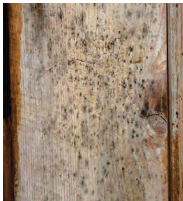
Fig. 15. Fungi filamentoși colonizând partea interioară a ușii.
