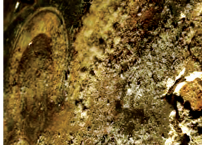
Fig. 36. Catapeteasma: eflorescențe sub formă de voaluri.
