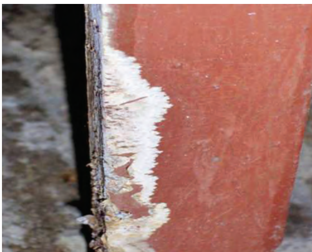
Fig. 21. Miceliu de Coniophora puteana în diferite stadii: creștere activă, maturitate, senescență.
