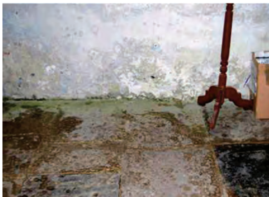
Fig. 14. Biofilm dezvoltat în pronaos: pe paviment și partea inferioară a peretelui.
