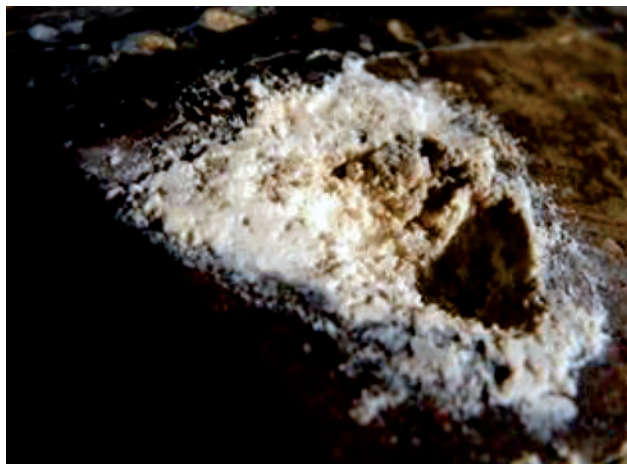
Fig. 34. Naos, eflorescențe compacte, perete sudic.
