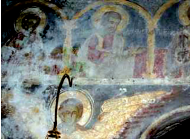
Fig. 35. Catapeteasma: eflorescențe sub formă de cruste.
