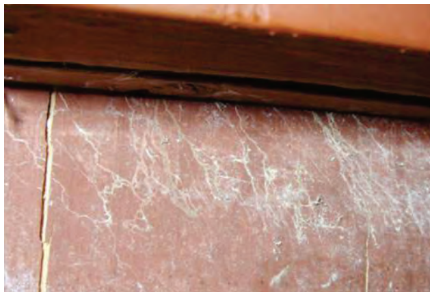
Fig. 20. Colonizarea lemnului din structura stranelor de către Coniophora puteana . Se remarcă rizomorfele.
