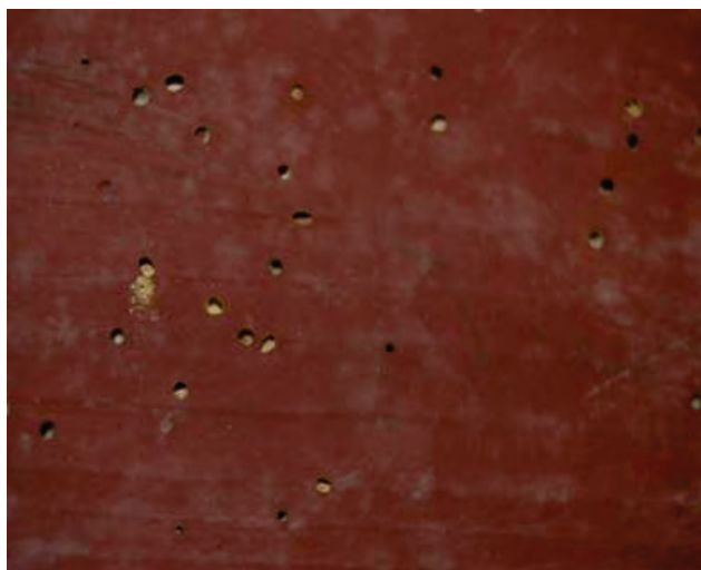
Fig. 22. Atac în desfășurare al insectelor xilofage, pe lemnul de suținere.
