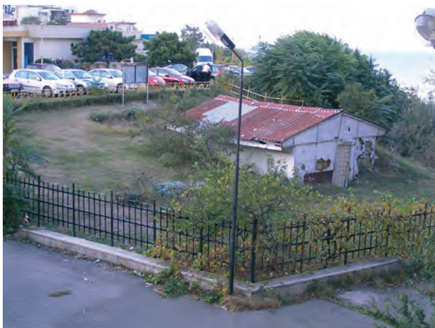
Fig. 14. Imagine de ansamblu a sitului și construcției „de protecție”.
