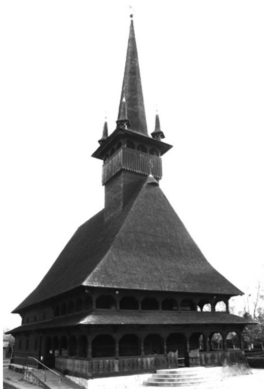
Fig. 8. St. Mina Church, Tăbăcăriei Park, Constanța.
