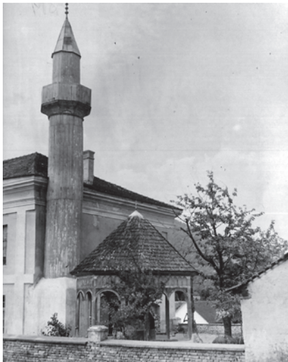
Fig. 9. La mosquée d'Ada Kaleh (première moitié du XXe siècle). Archives du MRPDF.
