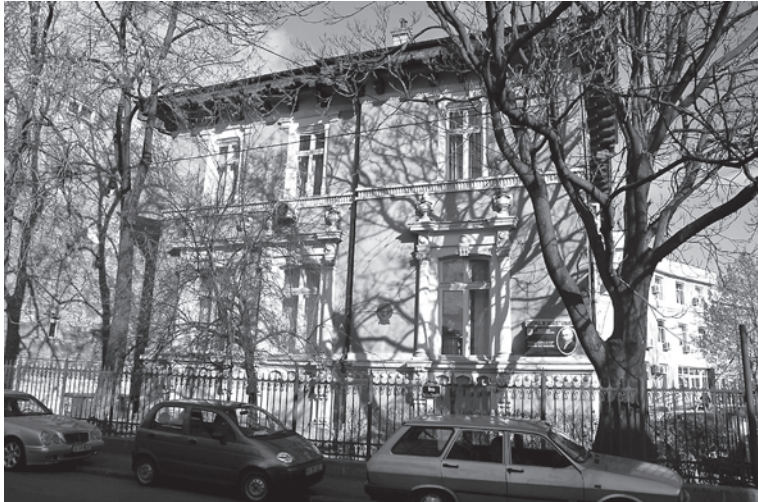
Fig. 12. Maison Robescu en Janvier 2012 (Photo architecte Petru Mortu).
