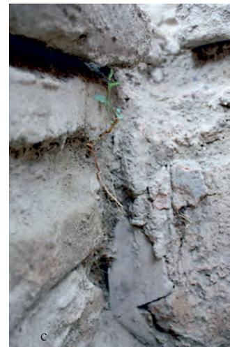
Fig. 6. Le bassin (a1) (*caldarium*): (a-b). Débris en marbres inclus pendant la réfection des parois du bassin (a1); c. Éclat de marbre réutilisé pour la réfection de la paroi est du bassin (a1).
